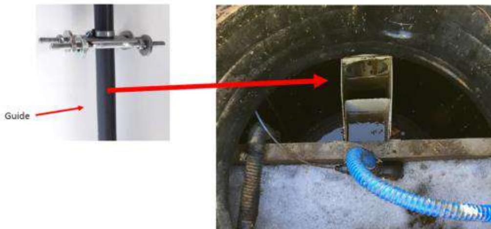
3. Serrer les écrous et contre écrous de manière que les rondelles maintiennent le guide en contact avec la chambre. De cette manière les vibrations du tuyau d'aspiration ne perturberont pas le prélèvement.
